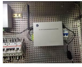
(d) Data acquisition unit installation.
